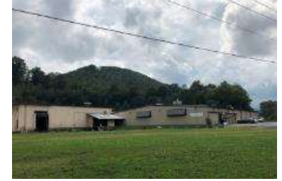
Plant-II, Emporium USA
